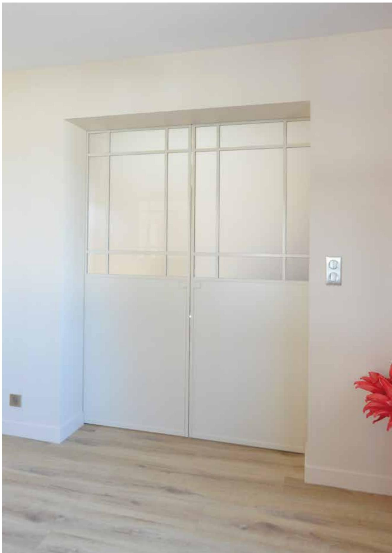
Double portes coulissantes aluminium FACTORY, posées dans un châssis à galandage
